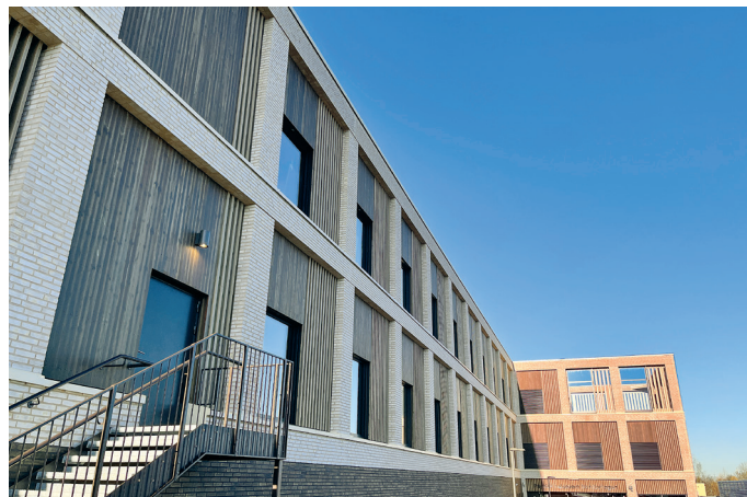
Den nye voksenavdelingen har et bruttoareal på cirka 8.735 kvadratmeter, fordelt på fire etasjer.
