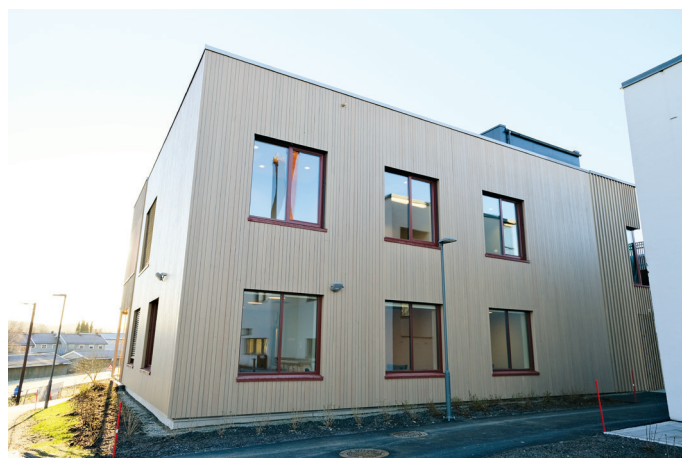
Nybygget for barne- og ungdomspsykiatri har et bruttoareal på 1.045 kvadratmeter.
